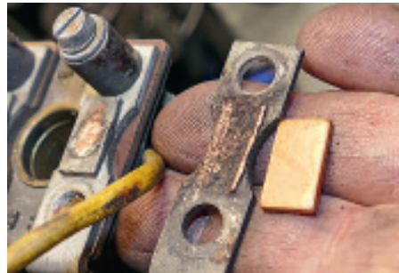
Reparaturlösung: Eine Platte aus spezieller Legierung wird auf den alten Kontakt aufgelötet und sorgt für verlustfreie elektrische Verbindung
