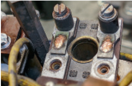
Normaler Abbrand: Das „Brennbild“ dieses Kontaktpaars ist normal, außer einer kurzen Kur mit dem Handfräser gibt es nichts zu tun
